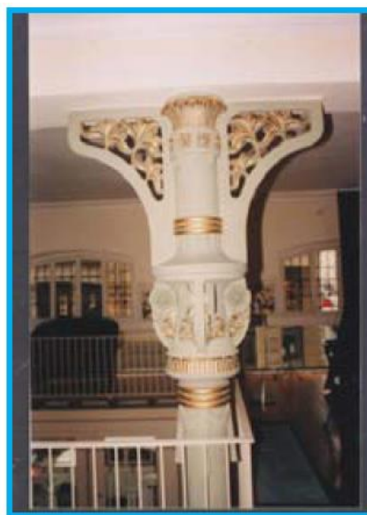
Lámina 19. Detalle de las columnas de fundición interiores. A.M.Z.
